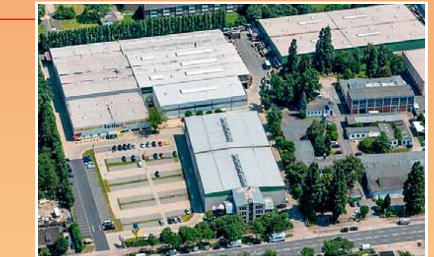
Die Renovierung der Schnittholzhalle und der Neubau einer weiteren Lagerhalle in Krefeld sind abgeschlossen
